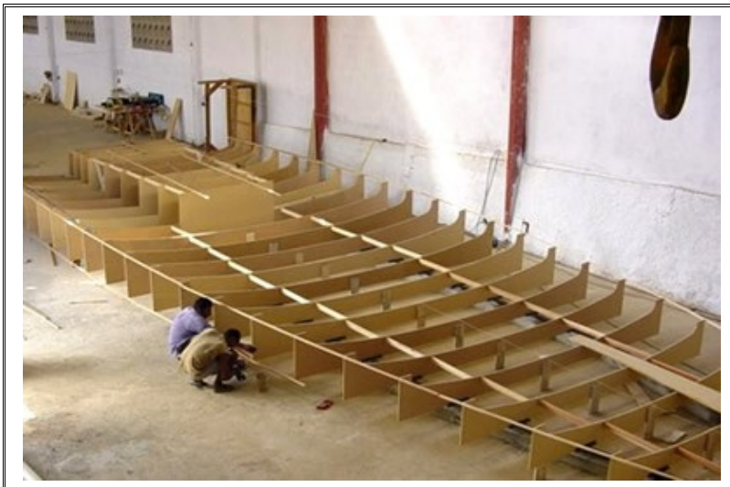
Construcción de modelo de cubierta.
